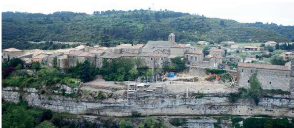
Fig. 2 : Cité de Minerve (Hérault), lices nord-orientales. Photographie du chantier de reconstruction de la cortine nord-orientale prise du nord-est de l'autre côté du ravin du Brian (photographie F. Loppe).
